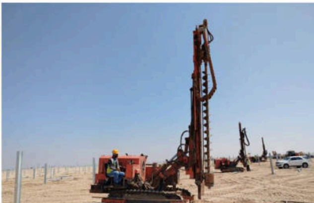
دقّ الخوازيق وتخطيط المصفوفة الأرضية، المرحلة 01
