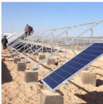
تركيب الهيكل الأرضي والألواح
